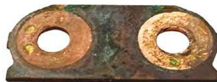
Rysunek 5. Uszkodzony łącznik modułów akumulatora trakcyjnego. Widoczne wypalenia i liczne wypalenia. Toyota Auris Hybrid
