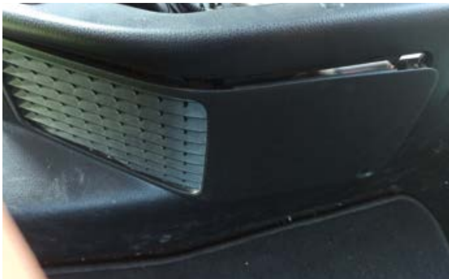
Fot. 4. Częściowo zdemontowana obudowa filtra wlotu powietrza akumulatora trakcyjnego
