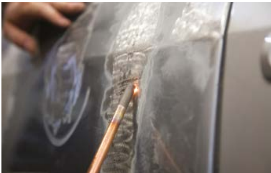
Fot. 7. Miedziana elektroda i spotter ustawiony w tryb pracy ciągłej pozwalają stworzyć narzędzie do obkurczania blachy i niepotrzebne staje się już używanie palnika ani podgrzewacza indukcyjnego. Źródło: Maciej Blum
