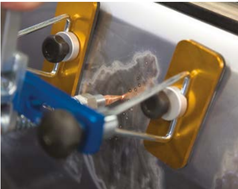
Fot. 3. Spotter służy do wyciągania pojedynczych punktów. Za jego pomocą naprawia się najmniejsze wgniecenia i wykańcza się powierzchnię po większej naprawie. Źródło: Maciej Blum
