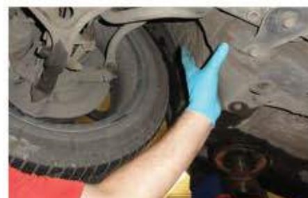
Rys. 4. Kontrola stanu zabezpieczenia antykorozyjnego
