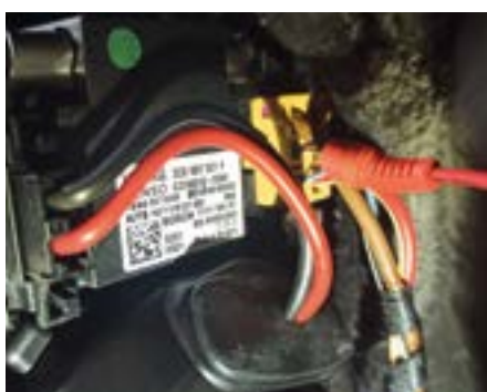
Fot. 2. Podłączenie sondy pomiarowej w złącze elektryczne wentylatora nadmuchu
